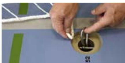
Filet et douille au sol avec mousqueton intérieur
