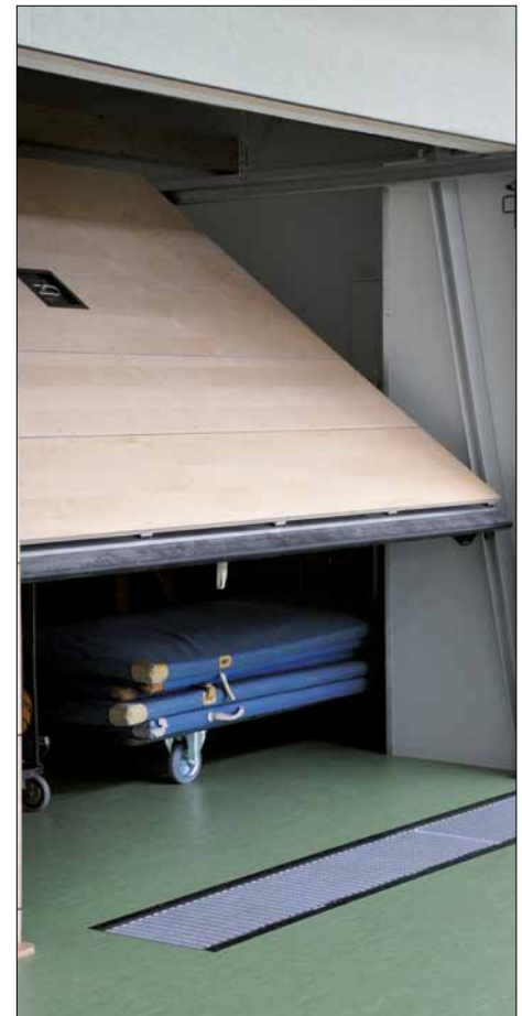
Das Tor schwenkt nicht in die Halle hinein (EN-Norm 13241-1).
